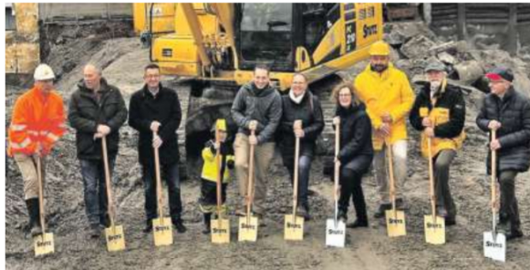
Spatenstich am 13. November 2023 unter anderen mit Alfred Müller, Verwaltungsratspräsident der Stutz AG, Gemeindepräsident Reto Friedauer, Leiter Bauverwaltung Reto Pallecchi und dem Architekten-Team der A. Somogyi AG. Bild: pd
